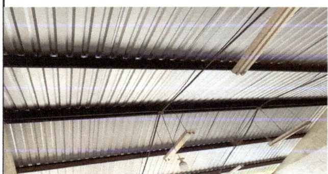
Foto 3: Aplicación de pintura en costaneras de metal
