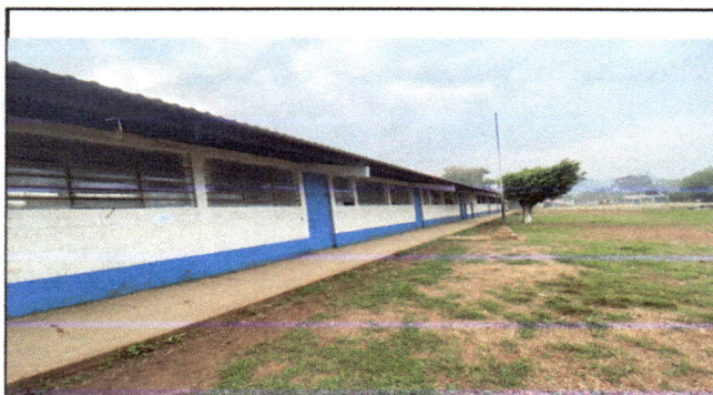
Foto 5: Aplicara pintura en las puertas
